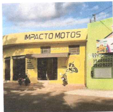
FOTO 3: Lateral direita com logradouro
